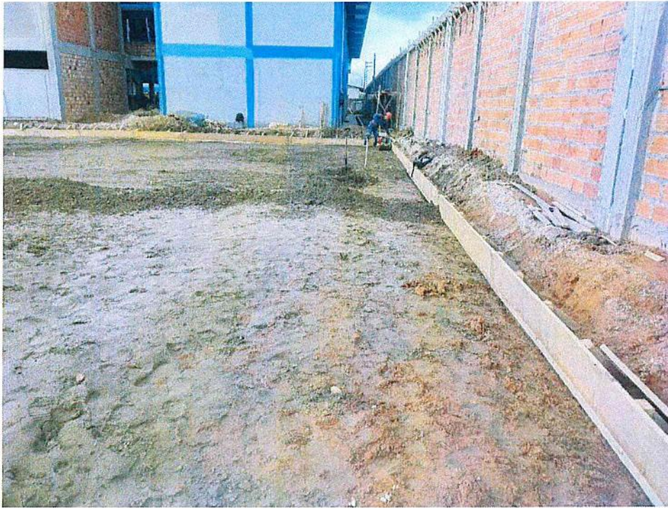
EN LA FIGURA SE MUESTRA EL ENCOFRADO DE LA LOSA DEPORTIVA.
