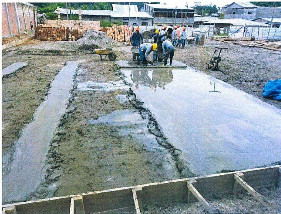
EN LA FIGURA SE MUESTRA EL VACIADO DEL SOLADO EN LA LOSA DEPORTIVA.
