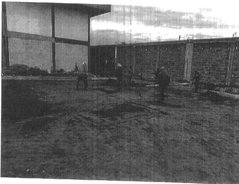
EN LA FIGURA SE OBSERVA LA COLOCACION DE LA CAMA DE ARENA EN LA ZONA DE LA LOSA DEPORTIVA
