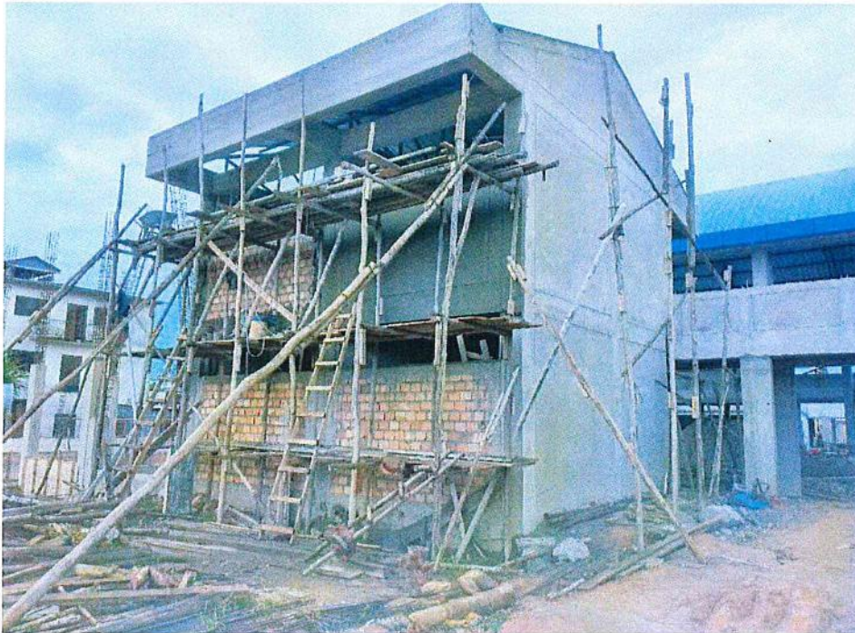
EN LA FIGURA SE OBSERVA EL TARRAJEO DE MUROS EXTERIORES EN EL MODULO DE SS.HH.
