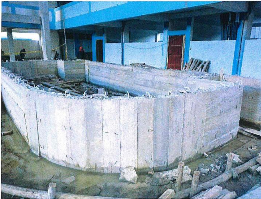
EN LA FIGURA SE MUESTRA EL VACIADO DEL ESCENARIO EN LA ZONA DEL PATIO DE FORMACION
